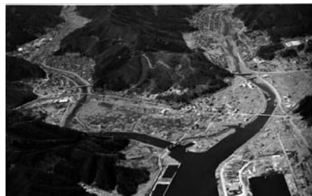
図6 岩手県上閉伊郡大槌町（震災後）
